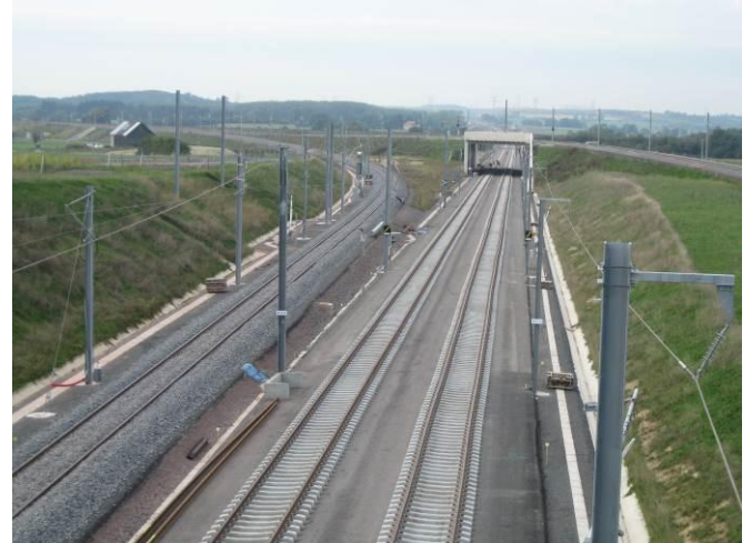
Blick auf die Neubaustrecke „LGV Est européenne“
