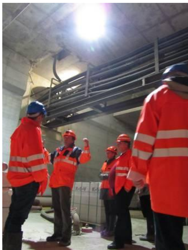
Herr Preisig vom Ingenieurbüro Basler&Hofmann führte über die Baustelle des neuen Bahnhofs „Löwenstraße“
