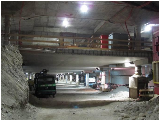
Blick in die zukünftige Bahnsteighalle des Durchgangsbahnhofs „Löwenstraße“
