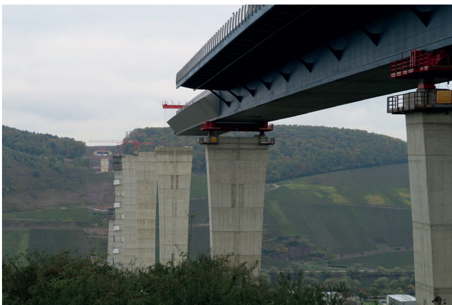
Vorschub des Hochmoselübergangs – Blick in Richtung Eifel
